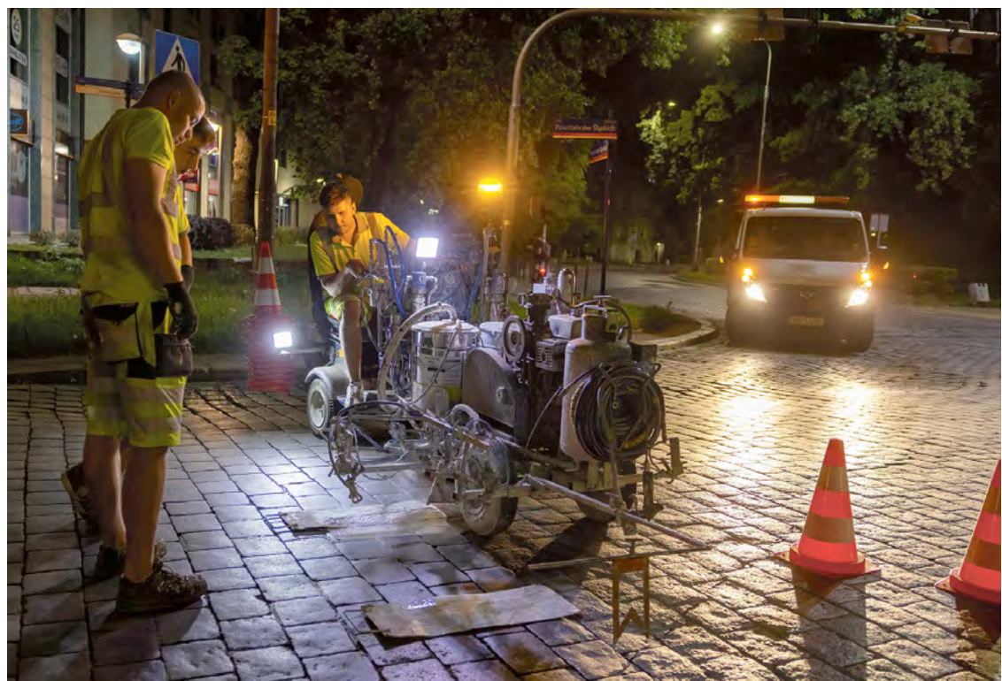
Prace drogowcy wykonują przede wszystkim w nocy, aby nie utrudniać ruchu samochodowego
